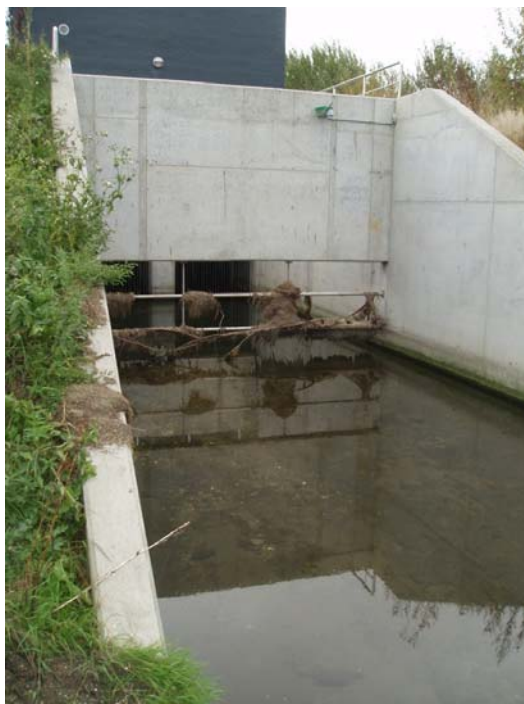
Figur 2.8 Prøvetagningsstedet ved pumpestationen i Østre Landkanal (Station 3).
