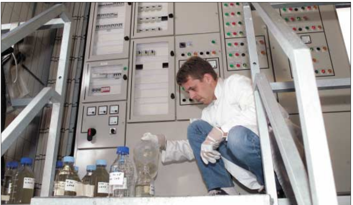
Ph.d.-studerende Kåre Press-Kristensen foran SRO-anlægget, der muliggør en nøje styring af det fuldautomatiske pilot-renseanlæg.
